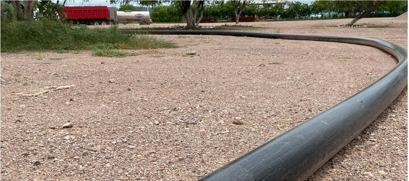
Instalación de tubería Pexgol para el transporte de agua con sólidos (plumas, huesos, vísceras, etc.)
